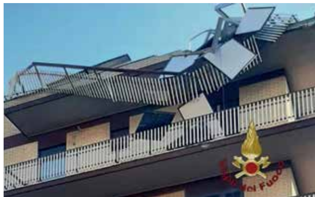
Figura 12 – Distacco di stringa di pannelli fotovoltaici a seguito di forte vento (Roma, luglio 2022)
