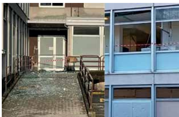
Figura 10 – Esempio di rottura di campiture vetrate durante una grandinata (Ospedale di Dolo, luglio 2023)
